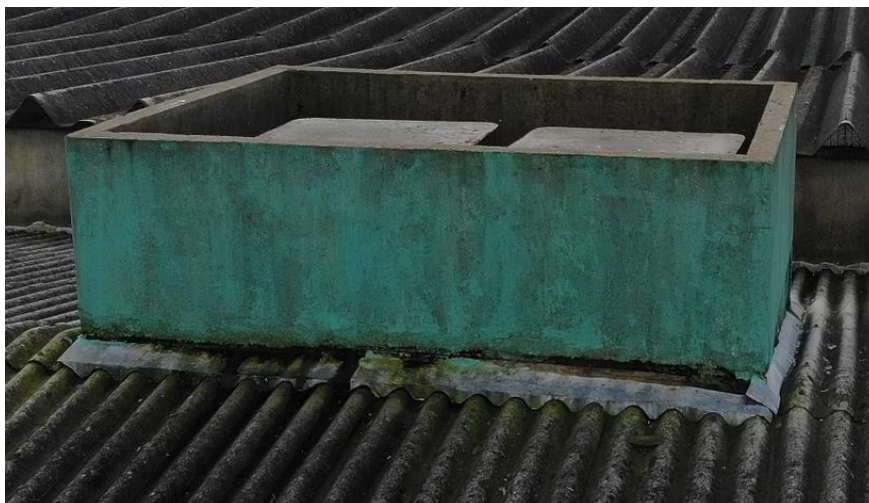
Imagem 03: Nicho dos reservatórios a ser impermeabilizado.
