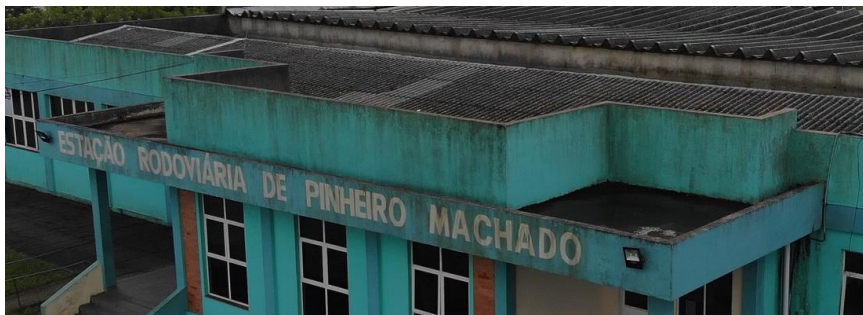
Imagem 02: Laje sobre o átrio a ser impermeabilizada.
