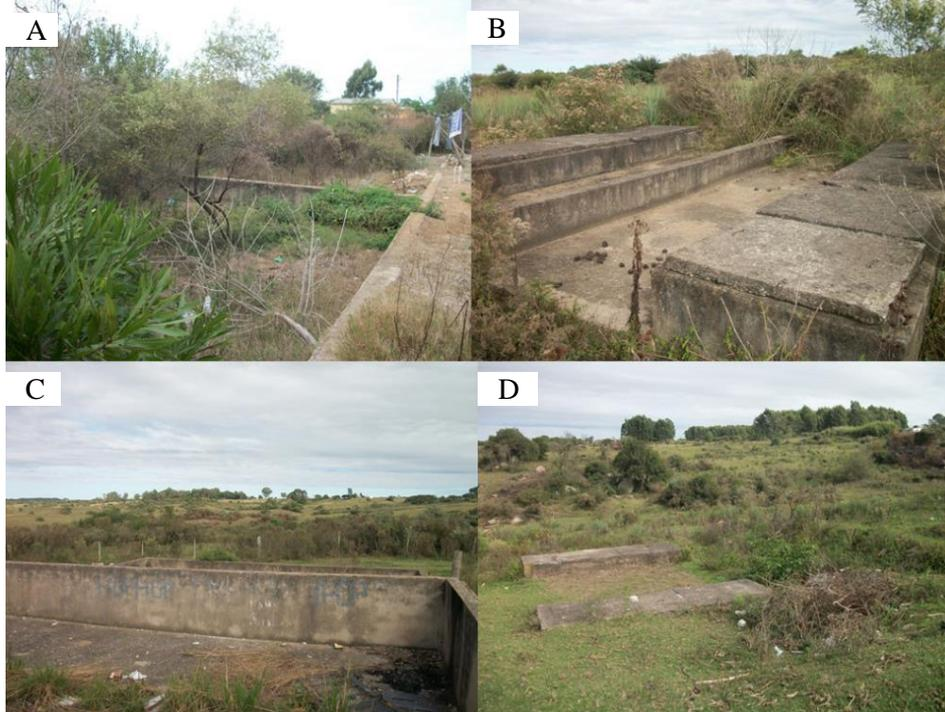
Assim, os esgotos das edificações existentes na área urbana do município são coletados por sistema de canalização, porém são desviados das estruturas projetadas para funcionarem como ETEs, sendo lançados a céu aberto, a exemplo do ilustrado na Figura 25, em local próximo à comunidade Menino Jesus. Por não haver sistema de tratamento de esgoto em operação, não há leitos para a secagem das lamas de esgoto.
